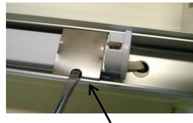
5. Leuchte nach vorne wegziehen, Stecker ausziehen und in der neuen Leuchte einstecken. (Achtung! Stecker bis zum Anschlag in die Lampe drücken) Neue Leuchte **LED** in`s Alu Profil einsetzen (Kleben)
