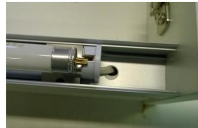
4. Blechklammer mit Schraubenzieher nach aussen wegdrücken und entfernen
